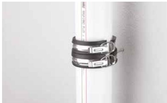
Рис. 86 Шумопоглощающий хомут в смонтированном состоянии
