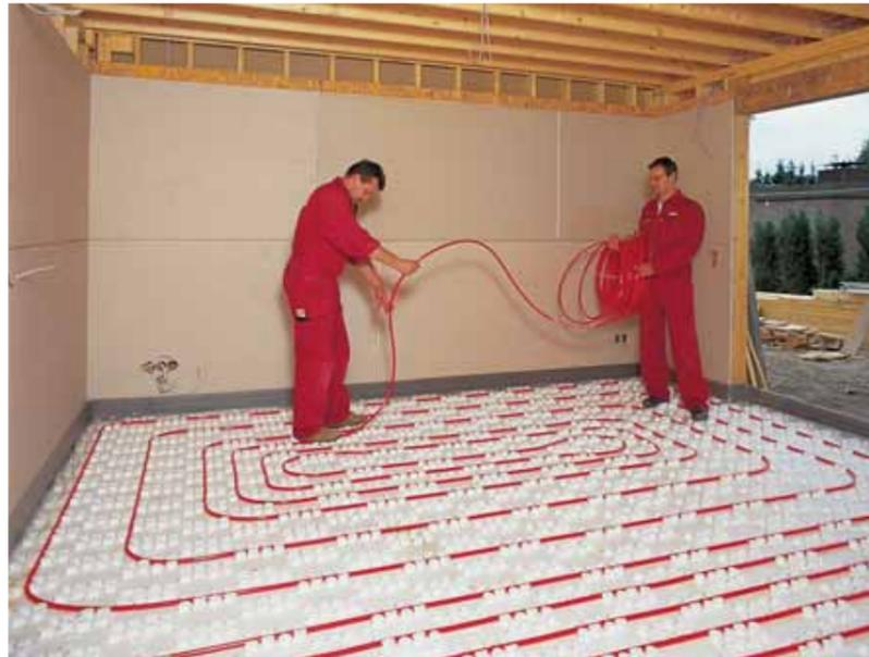
1 Рис. 9: Монтаж на матах с фиксаторами vario
