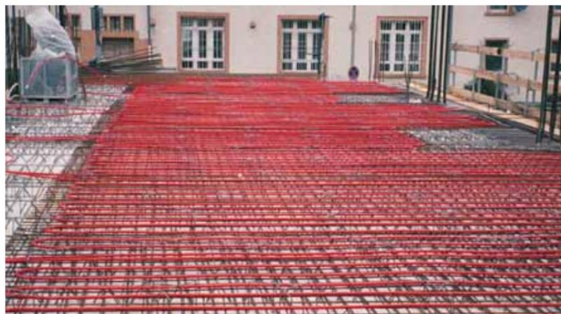
5 Рис. 4: Модуль ВКТ REHAU, закладываемый в перекрытие
