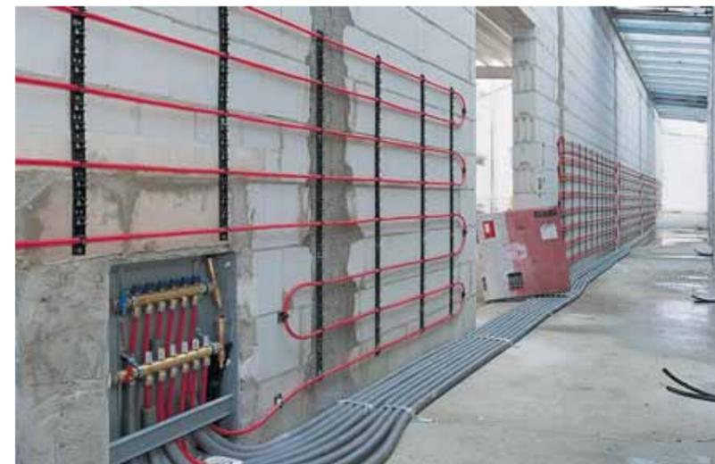
3 Рис. 10: Монтаж системы настенного отопления "мокрым" способом
