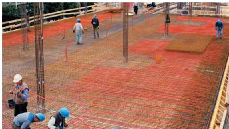
5 Рис. 5: Модули ВКТ REHAU, укладываемые на месте.
