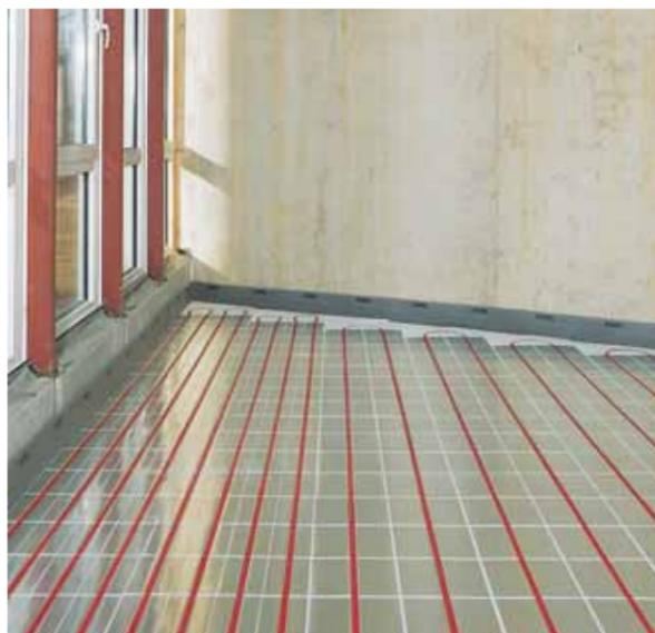
1 Рис. 5: Сухой способ монтажа для систем напольного отопления REHAU
