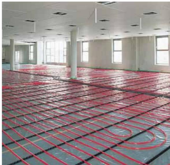
1 Рис. 3: Фиксирующие шины REHAU RAUFIX
