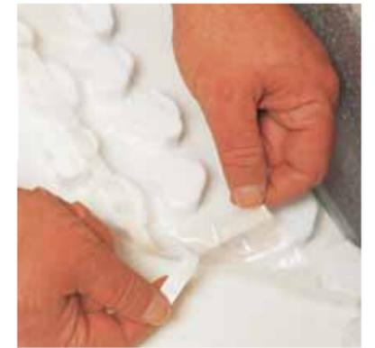
1 Рис. 41: Самоклеющаяся полоса на пленочном фартуке
