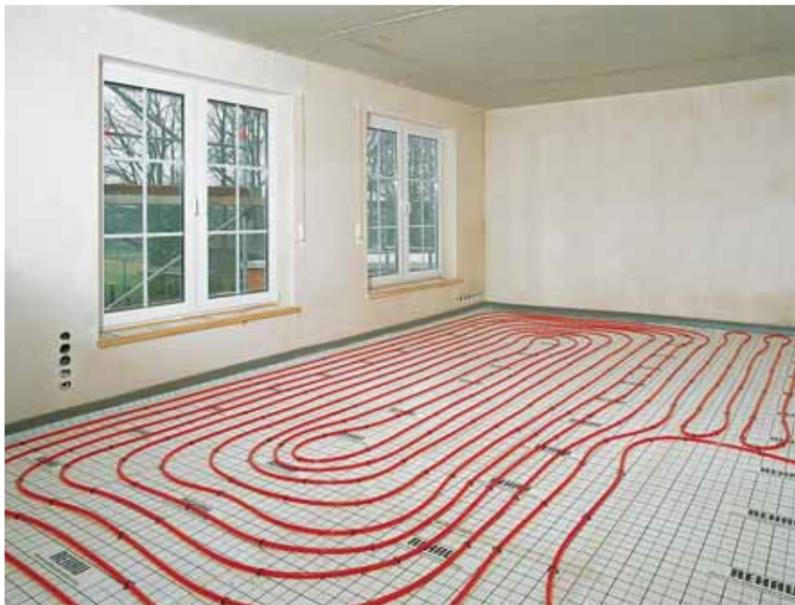
1 Рис. 15: Монтаж на матах с креплением трубы гарпун-скобой
